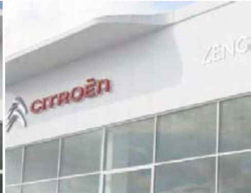
Kompozit panel uygulama, alüminyum doğrama, çelik takviyeli cephe sistemi
