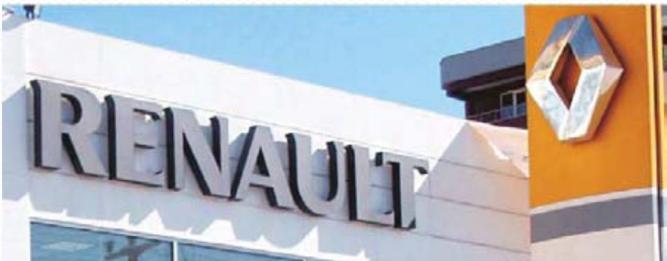
Kompozit panel cephe kaplama, alüminyum doğrama, çelik takviyeli kapaklı cephe
