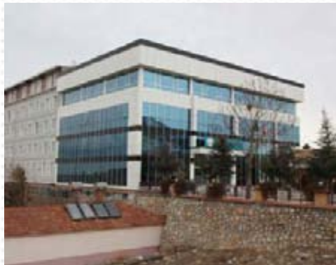
Silikon cephe , kompozit panel cephe kaplama, alüminyum doğrama
