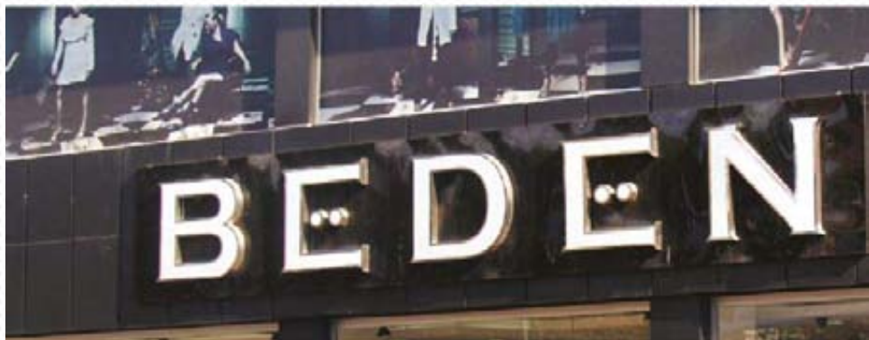
Kompozit panel cephe kaplama
