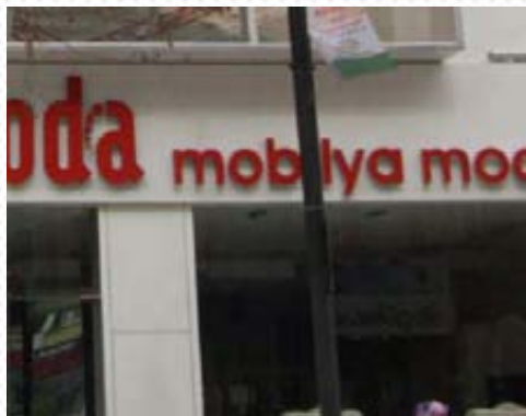
kompozit panel cephe kaplama
