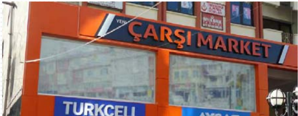
Kompozit panel cephe kaplama
