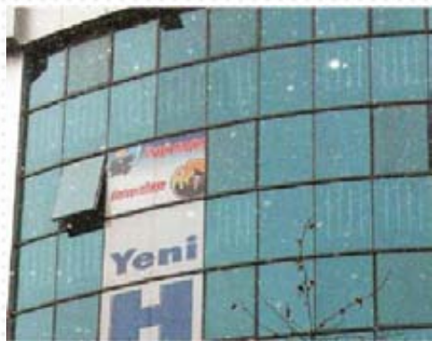
Silikon cephe , kompozit panel
