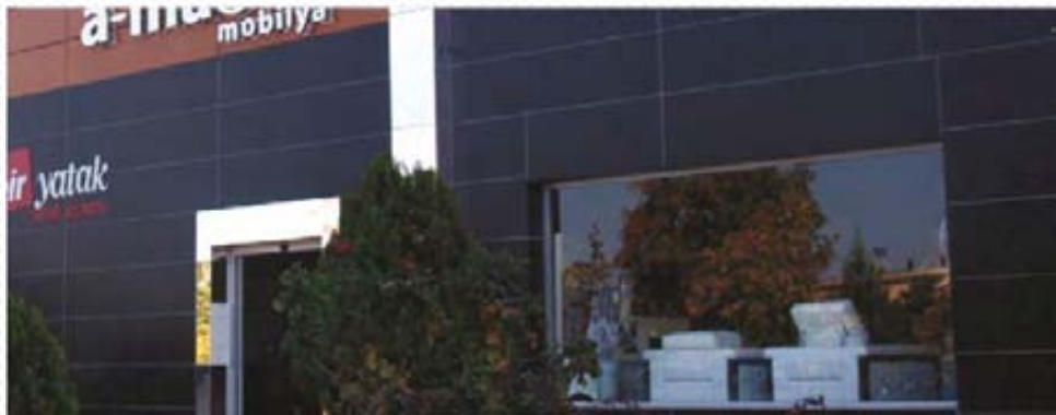
Kompozit panel cephe kaplama
