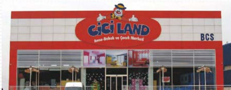
Alüminyum Doğrama, Cephe Sistemi Uygulama , Kompozit Kaplama
