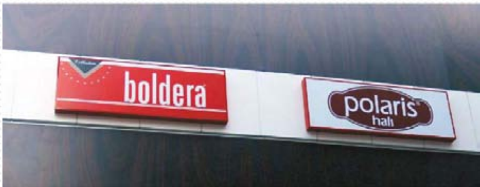
Kompozit panel cephe kaplama, vinil germe uygulama
