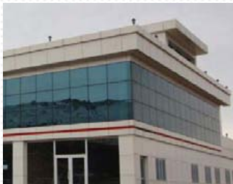
Silikon cephe , kompozit panel cephe uygulama, alüminyum doğrama
